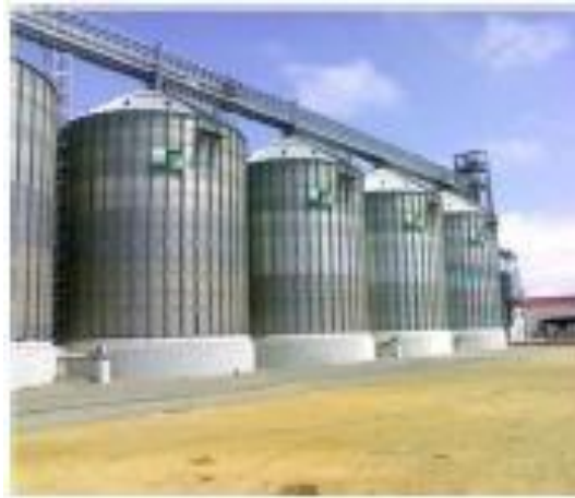
Fig. 2 Flat bottom silo
