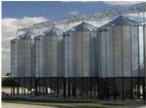
Fig. 3 Hopper silo
