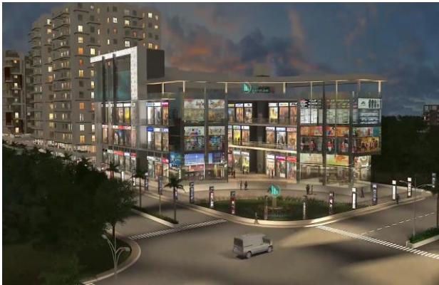
Fig 2: 3 rd eye view of actual site
