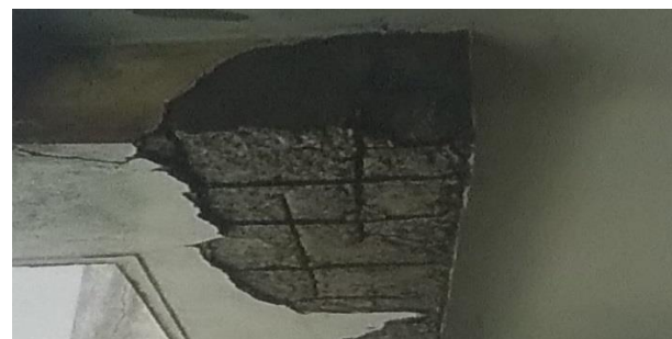
Spalling
