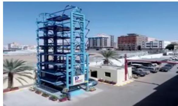
Fig3.12 : 3 rd Eye View Of Actual Site
