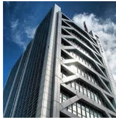
Fig 7:Eccentric bracing
